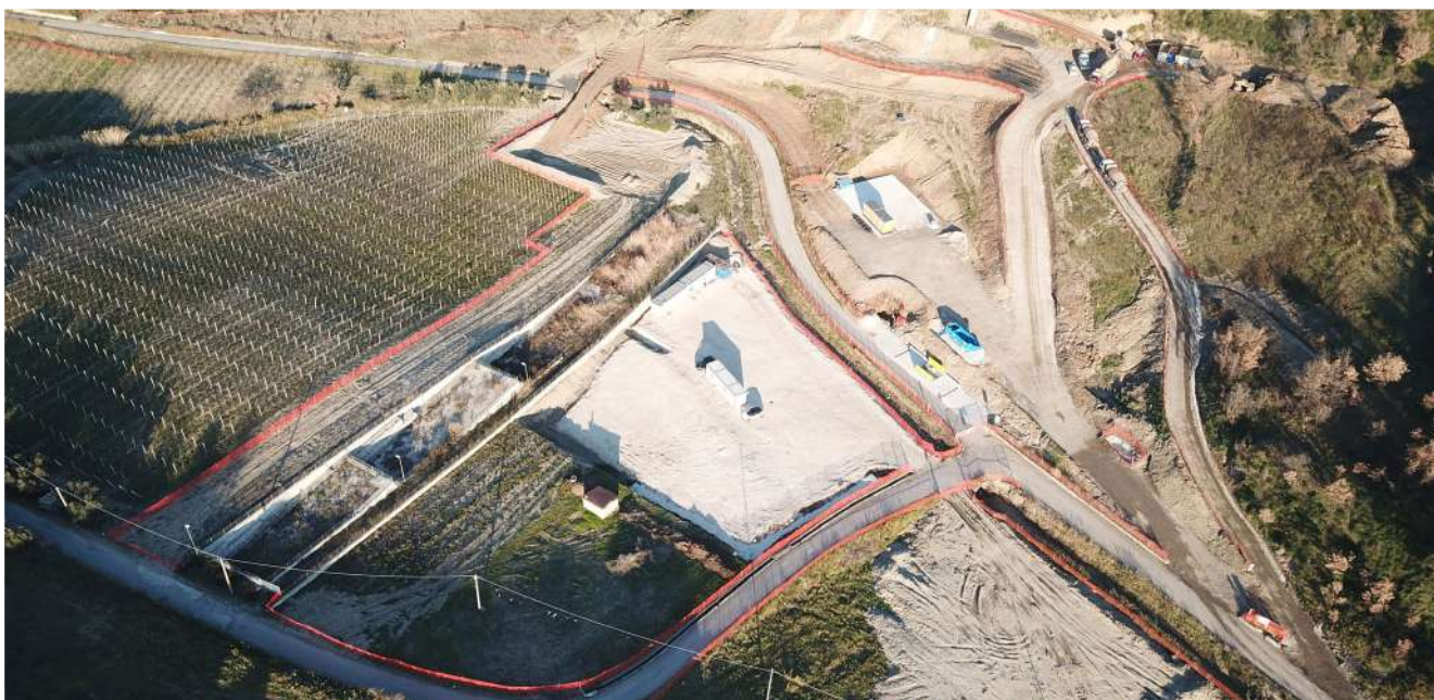
Cantiere per la realizzazione della linea AV/AC Napoli Bari
