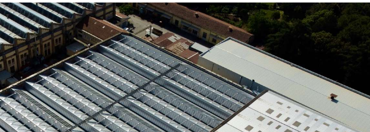
Impianto fotovoltaico, Officina Manutenzione Ciclica Locomotive di Foligno
