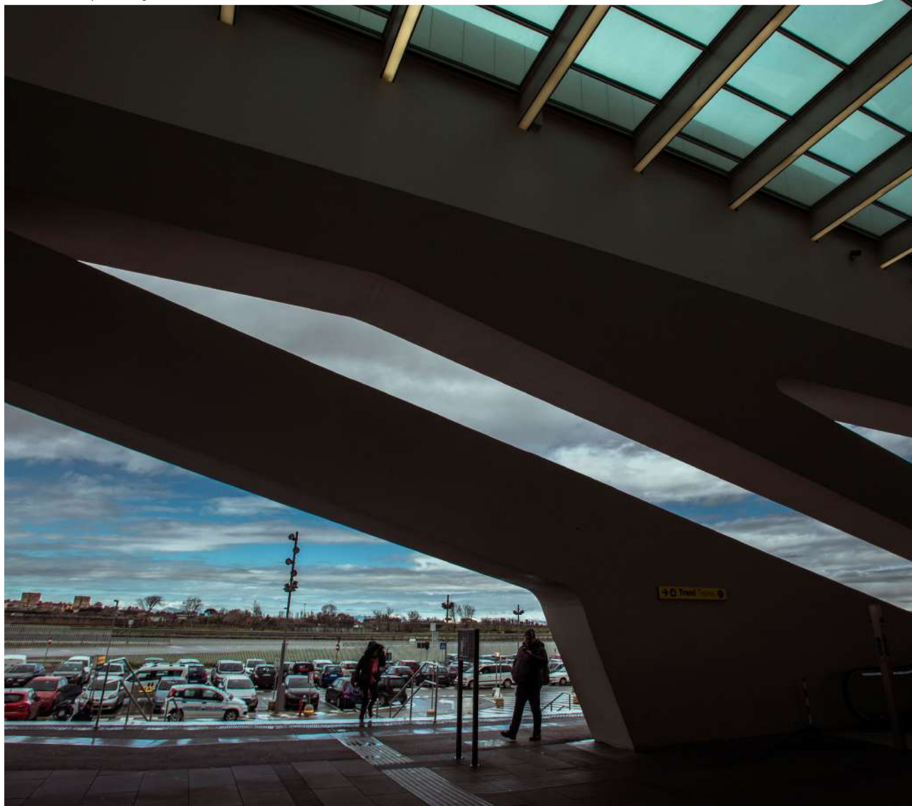
Stazione di Napoli Afragola
