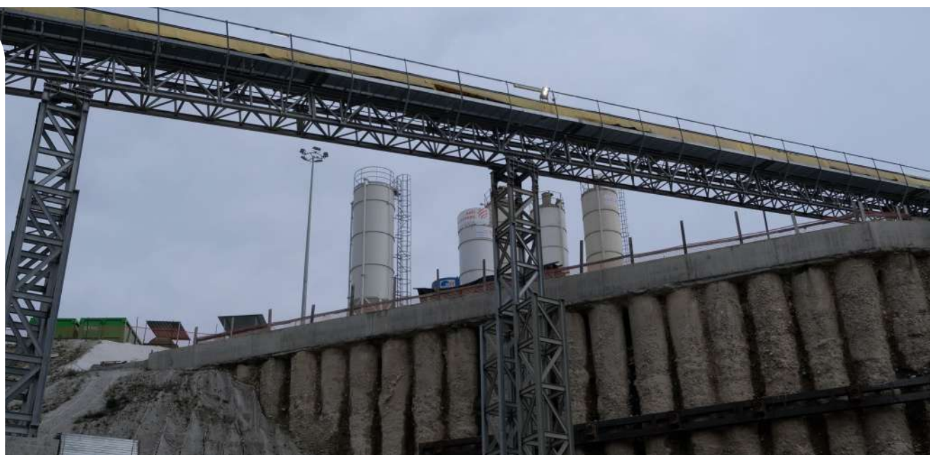
Cantiere per la realizzazione della Galleria Lonato
