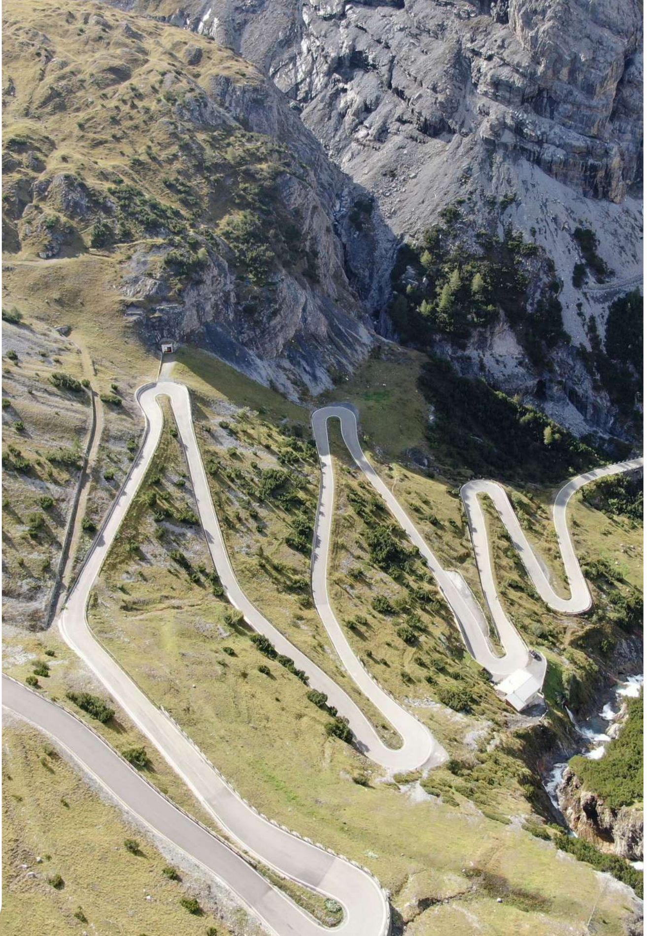
Strada Statale dello Stelvio, Anas
